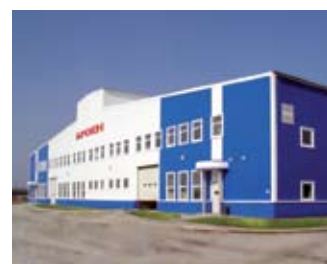
Производственный комплекс BROEN в Коломне
