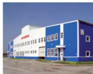
Производственный комплекс BROEN в Коломне
