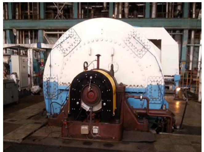
Рис.14. Проверка на биение валопровода турбогенератора ТВФ-63-2 ст.№7
