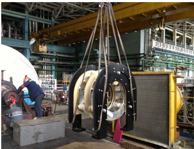
Рис.13. Монтаж модернизированного ЩКА SV1344 R02
