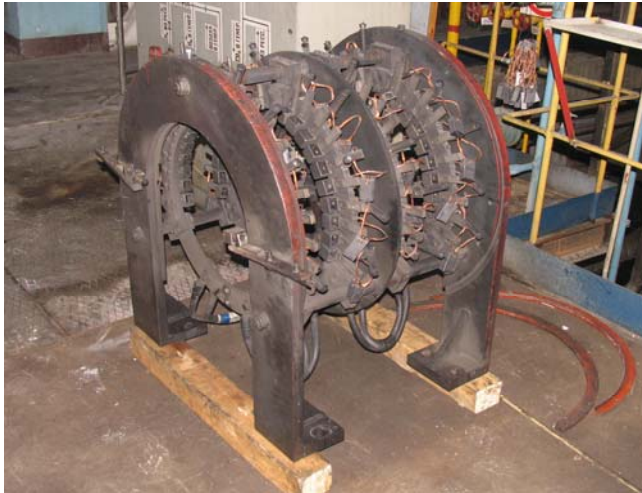
Рис.9. Демонтаж штатного ЩКА
